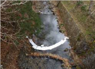
【オイルマット設置】
