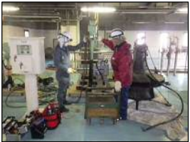
【施設の改修状況】
